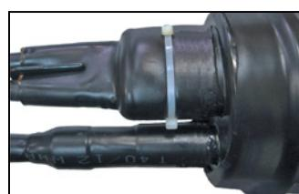
**Примечание:** При усадке на патрубок оголовника муфты ТУТ, на внутренней поверхности которой у одного из торцов имеется участок без клея-расплава, этот участок следует ориентировать в сторону оголовника. При усадке такого отрезка ТУТ за счет наличия у нее участка без клея-расплава предотвращается сползание ТУТ, т.е. не требуется закрепление ТУТ на патрубке в ходе ее усадки.
